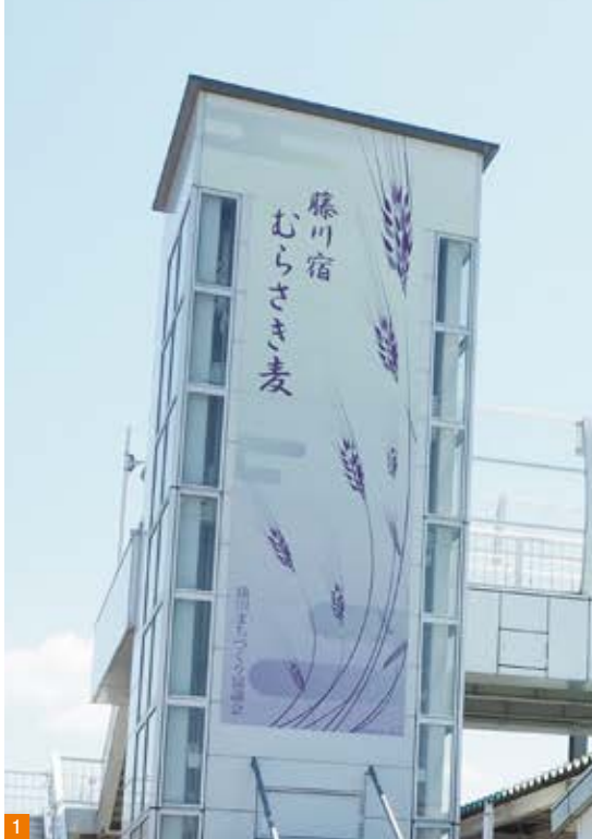
1 跨線橋エレベータの側面
