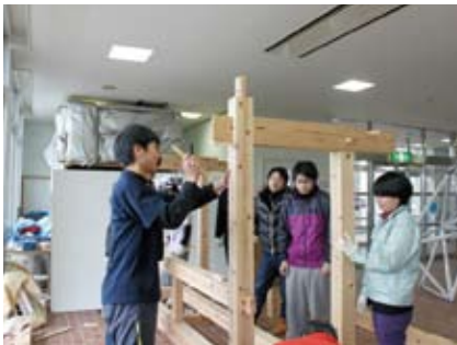
▲ 「木造計画設計II」棟梁・中村武司先生と共に伝統工法(木造軸組み工法)による茶室外腰掛待合を制作
